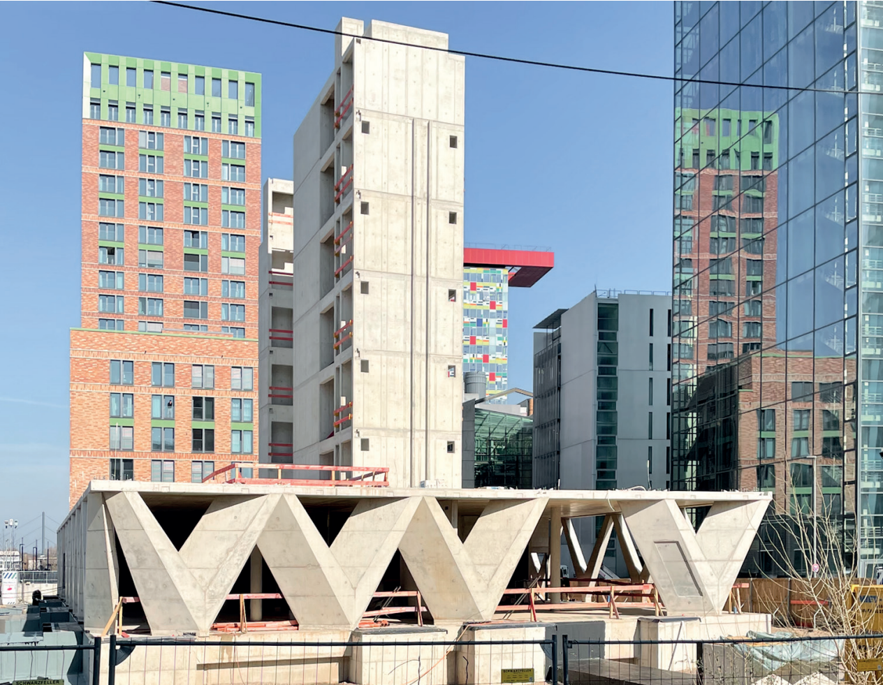
Baustelle im April 2022: Betoniertes Erdgeschoss und Start der Holzbauarbeiten in den Obergeschossen
