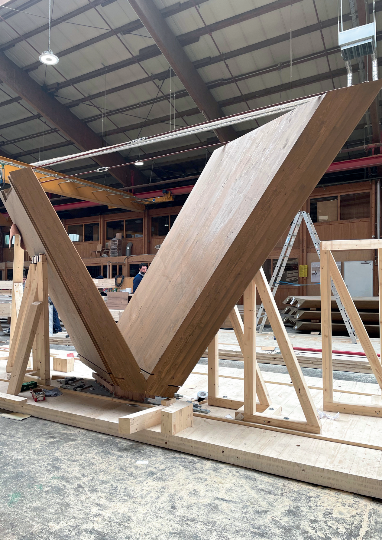
Vorfertigung der Holzstützen im Werk
